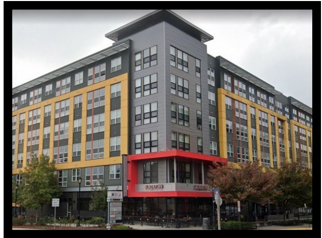
34) HALSTEAD SQUARE LOFTS
