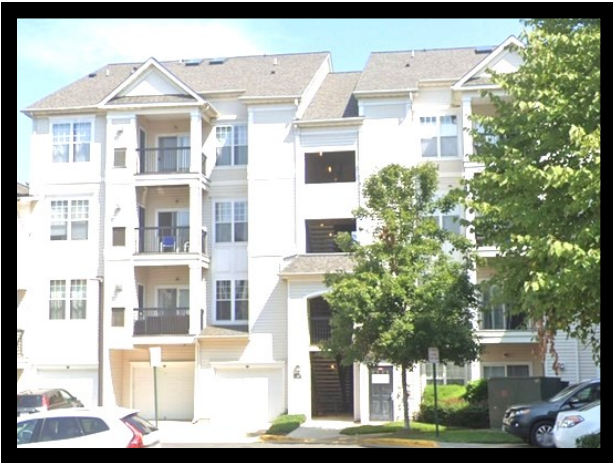
31) RADIANT FAIRFAX RIDGE
